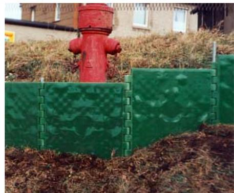
**Die Platten sind beliebig horizontal und vertikal versetzbar. Durch die Scharnierbauweise kann die Mehrzahl der Hindernisse innerhalb der Leiteinrichtung umgangen werden.**
