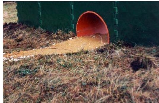
**Zum Anschluss an Straßendurchlässe aller Art (Rohr- und Kastensysteme) Platten aussägen(Stichsäge). Zaun-Element und Durchlassbereich mit Füllstoff (Beton, Kleber oder Bauschaum) verbinden. Auch Anbindungen an Altsystemen sind möglich!**
