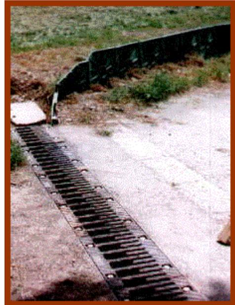
**Es besteht die Möglichkeit einfach aus 3 Elementen einen Richtungsweiser zu montieren. Hierdurch werden die Amphibien besser zu den Durchlässen geleitet.**
